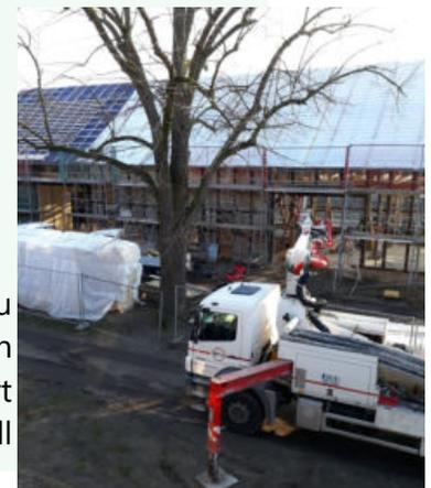
Die Arbeiten am 3. Bauabschnitt der Tagesförderung/Sanierung und Umbau der Scheune zur Schaffung von Räumen gemeinsamer Tagesförderung gehen gut voran. Inzwischen wurde die Bodenplatte gegossen, das Fachwerk erneuert sowie die Öffnungen für die künftigen Türen und Fenster hergestellt. Aktuell erfolgen der Einbau der Tockenbauwände und die Ausmauerung der Gefache.
