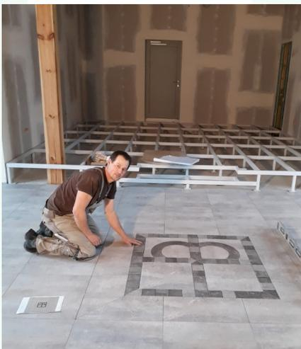
Herr Wilczynski bei der Fertigung des Kronenkreuzes im Fußboden der Scheune; im Hintergrund ist der Unterbau der Bühne zu sehen.
